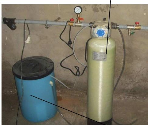
Это ионообменный фильтр, который представляет собой сосуд из армированного стекловолокна, заполненный слоями материала, называемого ионитом или ионообменной смолой, и обычно представляющим собой гранулы диаметром от 0,5 до 1,0 мм.
